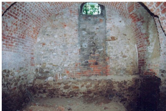
Ryc. 2 Zachodnia piwnica w paśmie środkowym, widok na przebudowaną ścianę zachodnią – stan dzisiejszy.
